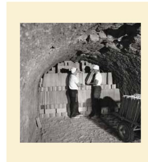
Scarico del forno dopo la cottura
